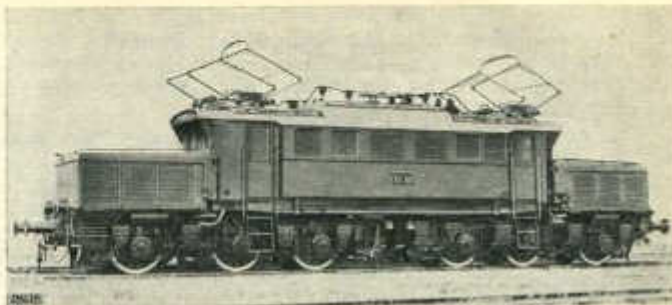
Abb. 15. C 0 -C 0 -Güterzuglokomotive Reihe E 93 der Deutschen Reichsbahn-Gesellschaft mit Antrieb durch Tatzenlagermotoren.
