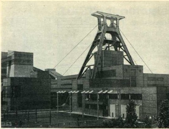
Abb. 7. Außenaufnahme mit Blick auf das Fördergerüst.
