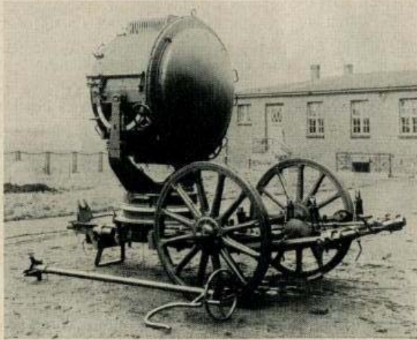
Abb. 1. Scheinwerfer, 110 cm, auf pferdebespanntem Proßfahrzeug. (Weltkrieg.)
