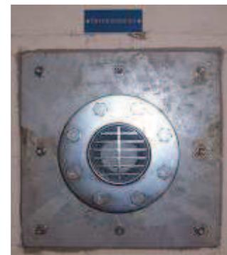
Bild 6.26, Überdruckventil
