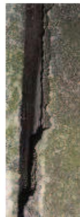
Bild 6.33, Setzung in der Fassade
