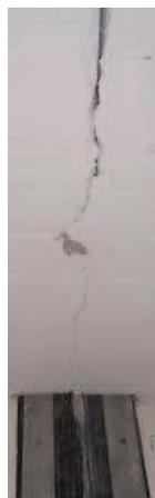
Bild 6.32, Setzungsrisse
