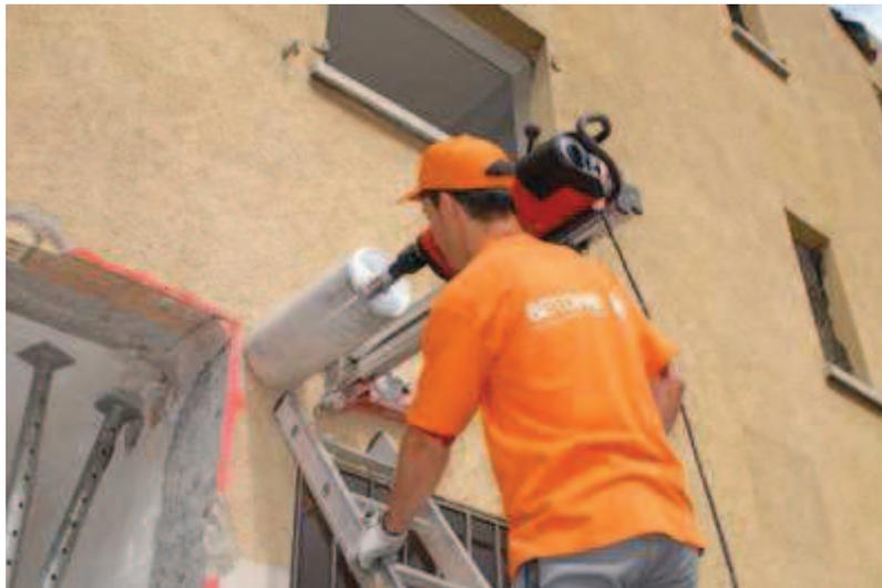
**Bild 11.1, Beispiel für das Betonbohrverfahren**
