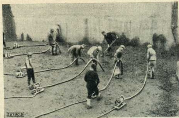
Bild 5. Baustelle mit Innenrüttler zum Verdichten des Betons einer Talsperre.
