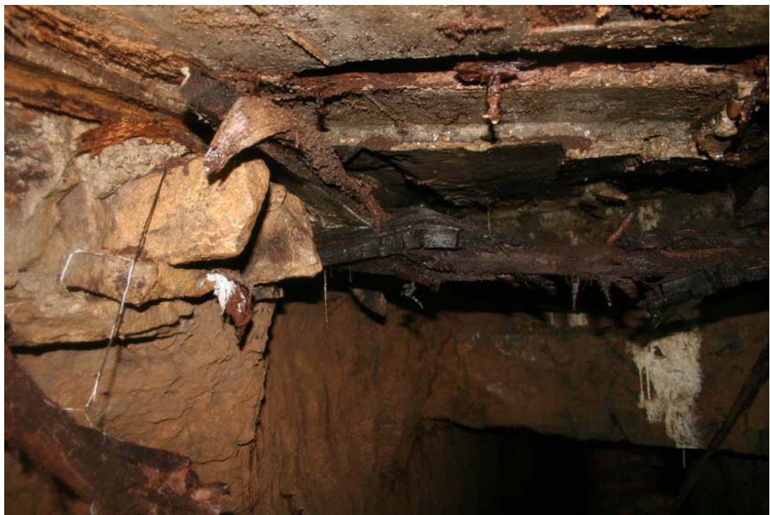
Ehemals auf Rundhölzern aufgelegte Decke im Eingangsbereich – Decke liegt auf Lehm
