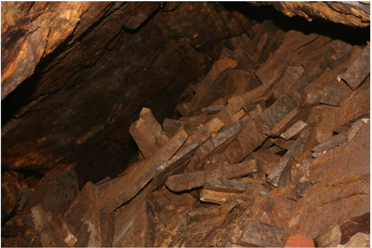
Verbruch im LSR- Bereich
